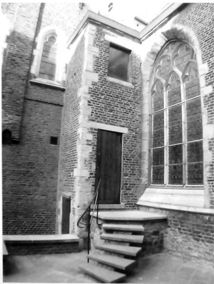
De klokkentoren is niet bereikbaar vanuit de kerk, maar heeft een aparte ingang aan de achterzijde van de Sint-Bartholomeuskerk
