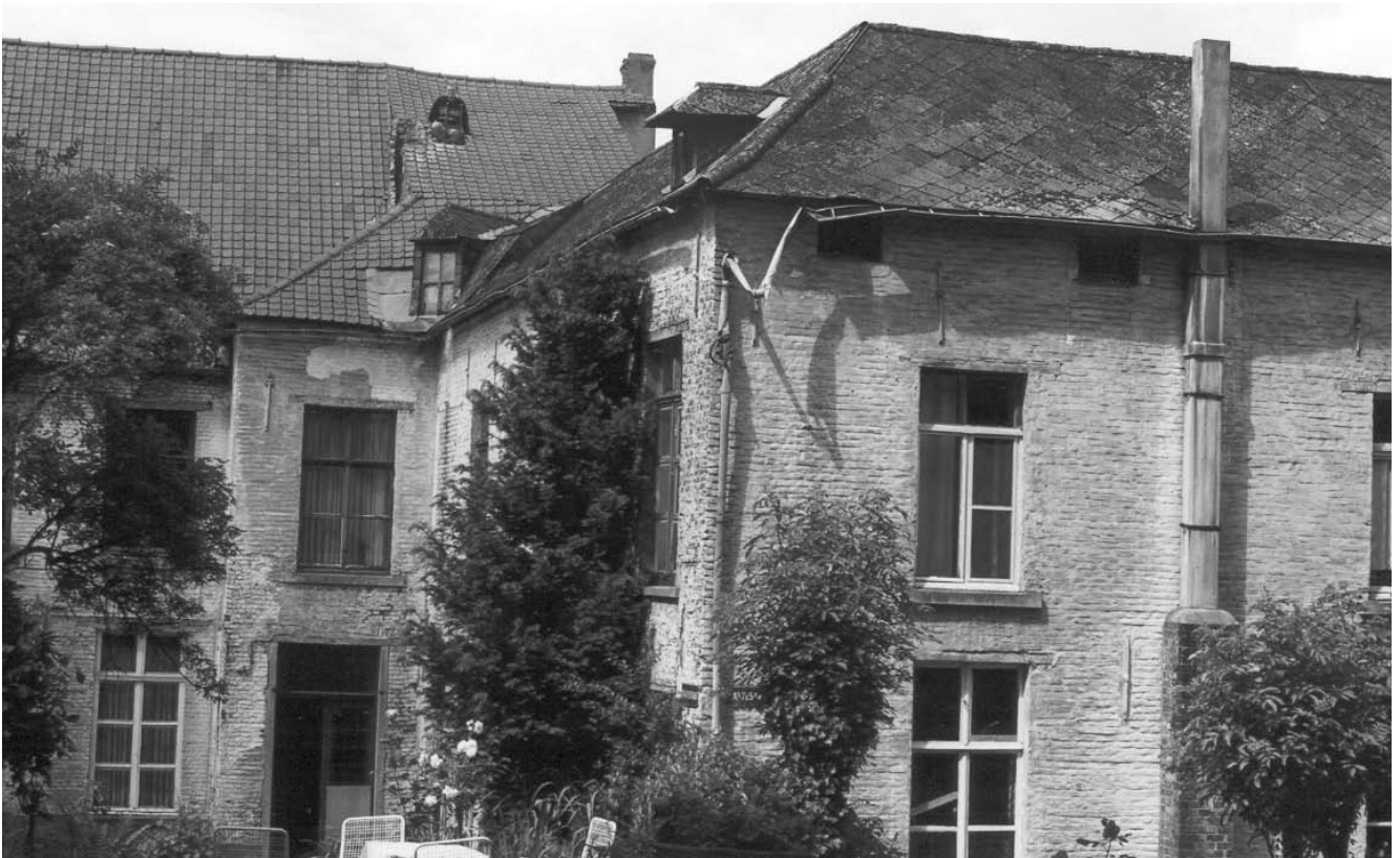
Afb. 11: zicht op de achterzijde van het pand.
