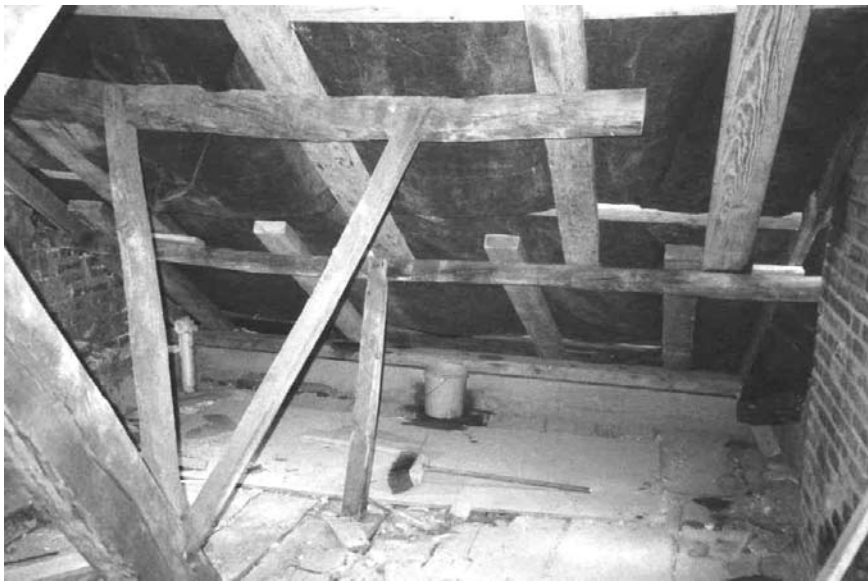
Afb. 8: binnenzicht van het dak van het hoofdgebouw vóór de restauratie
