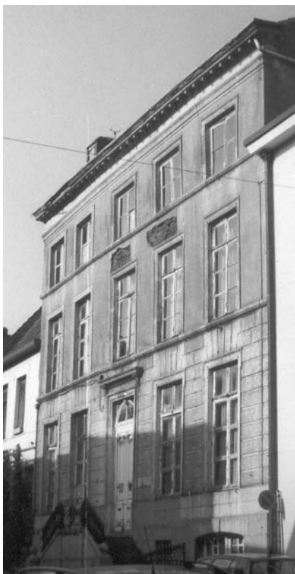
Afb. 9: zicht op de voorgevel kort voor de restauratie
