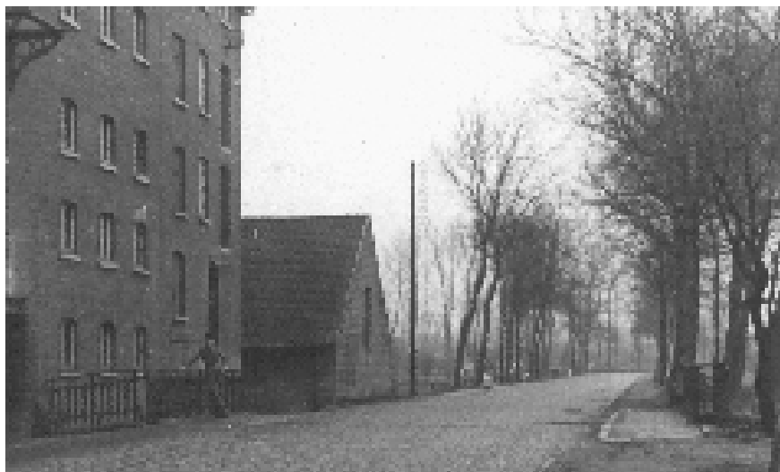
Afb. 51: de maaldrijgebouwen langs de straatzijde (1949)
