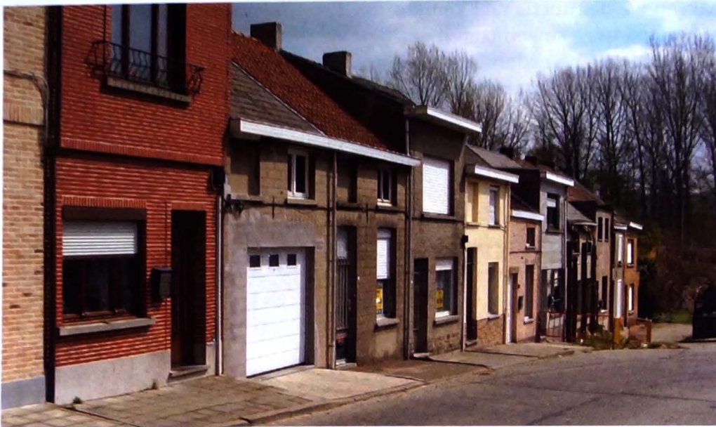
De lucifersfabriek en het directeurshuis van Guillaume Mertens zijn volledig gesloopt, maar de 12 arbeidershuizen in de Fabriekstraat staan er nog. Deze sterk verbouwde woningen uit 1860 zijn de eerste en ook de oudste in hun soort die door een industrieel in het Geraardsbergse zijn opgetrokken. (Foto J. De Ro)
