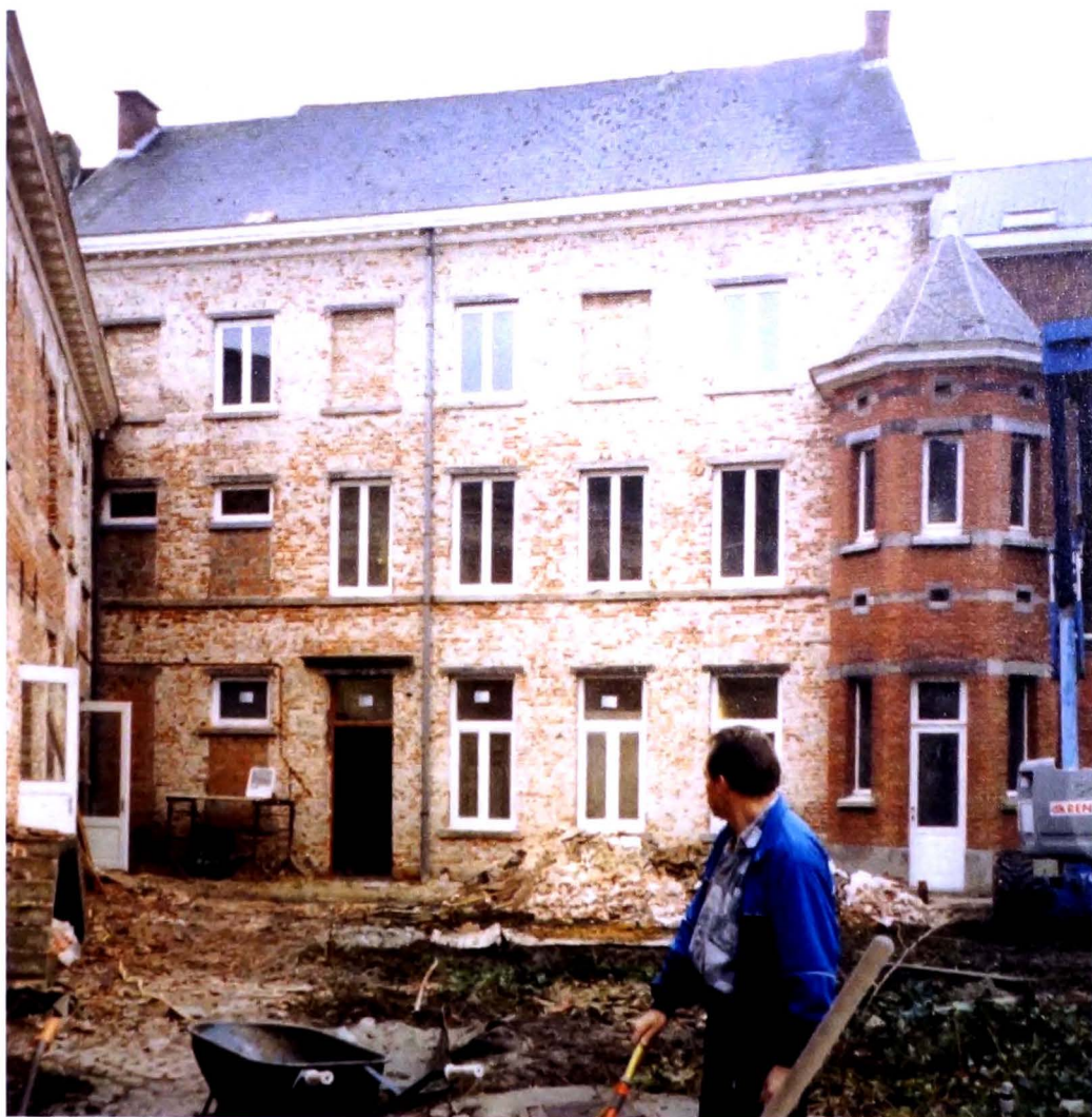
Alvorens een bepleistering wordt aangebracht, worden de tuingevels voorzien van nieuwe ramen en deuren. Het zeshoekige torentje behoudt zijn vroeger uitzicht. (Verz. G. Coppens)
