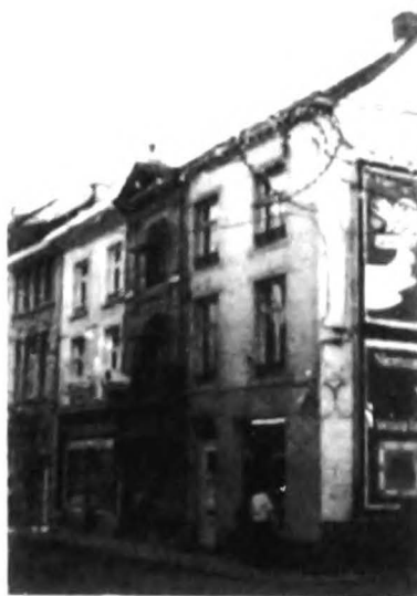
Zicht op de voormalige voorgevel van brouwerij 'De Kat' langs de Grotestraat, hier in 1978 opgedeeld in drie woonhuizen waarbij de benedenverdieping is verbouwd tot winkelruimte (Inventaris Rijksdienst voor Monumenten- en Landschapszorg).
