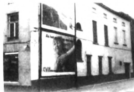
Zicht op een deel van de straatgevel van de voormalige brouwerij 'De Kat' langs de Kattestraat in 1978 (Inventaris Rijksdienst voor Monumenten- en Landschapszorg).
