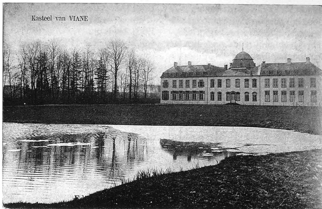
Het kasteel - 1911. De prentkaart toont de achtergevel van het hoofdgebouw met op de voorgrond de kasteelvijver. Het bakstenen gebouw dateert uit de tweede helft van de achttiende eeuw. Het vormt een lange vleugel van drie aan elkaar sluitende delen. De middenbouw is iets ouder en stond oorspronkelijk alleen. Hij wordt bekroond door een achthoekige koepel. De twee aanpalende vleugels staan lichtjes haaks op de torenconstructie ingeplant.
