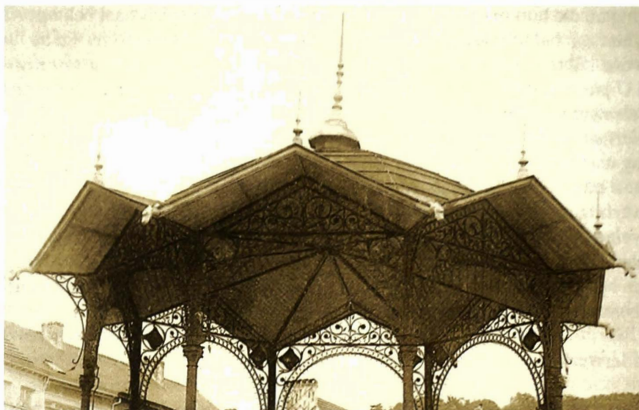
Het koepeldak met afdaken, spitsen en waterspuwers, geschraagd door gietijzeren kolommen. (Foto Th. L'Haire) (Verz. Ph. Haegeman)
