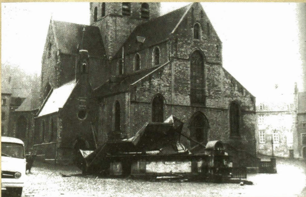
Het einde nabij... De gietijzeren constructie wordt door kabels, verbonden met een lichte vrachtauto en een kleine rupskraan, neergehaald.
