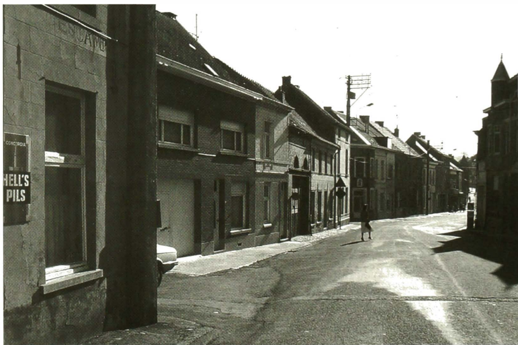
De Oudenaardse Poort voor de aanleg van het viaduct
