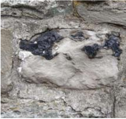
Doornikse kalksteen in de Sint-Bartholomeuskerk. De zwarte vlekken zijn chertnodules.
