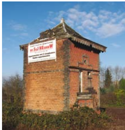
Dit torentje langs de Pelgrimsweg wacht op de sloop (december 2006) (Foto J. De Ro)
